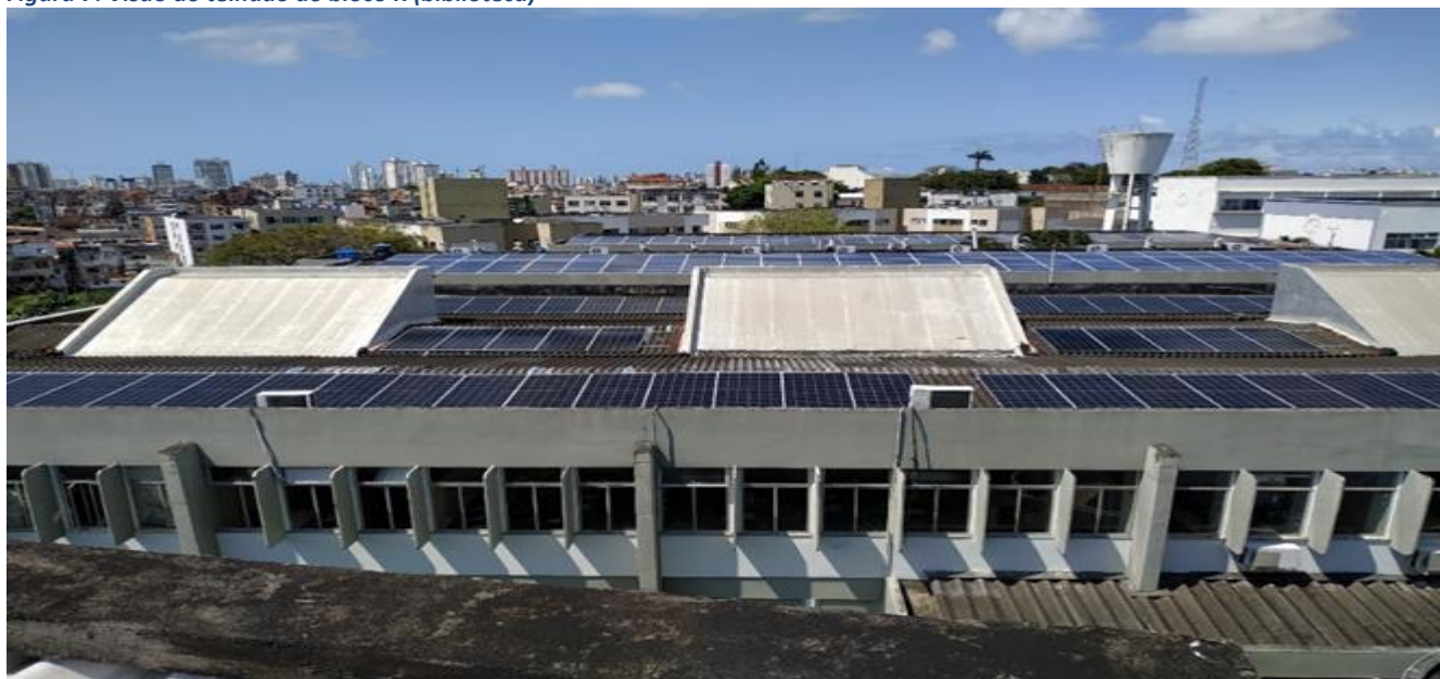
Figura 7: Visão do telhado do bloco K (biblioteca)
