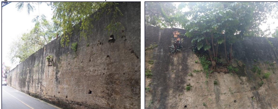
Figura 3: Muro de Arrimo - Campus de Salvador
